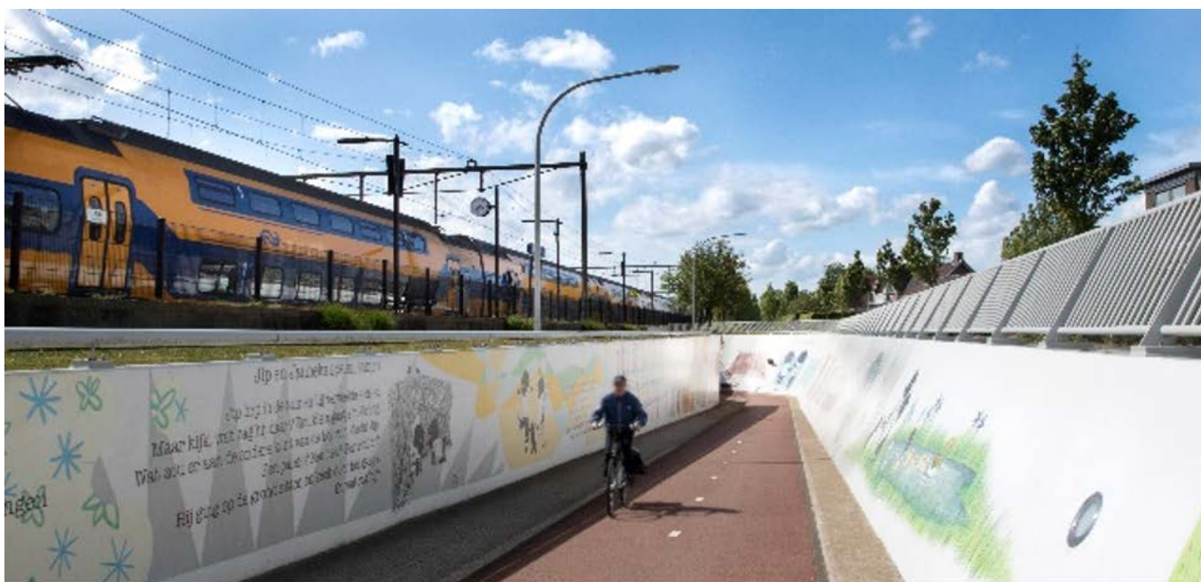
Figuur 10 Fietstunnel Kapelle
