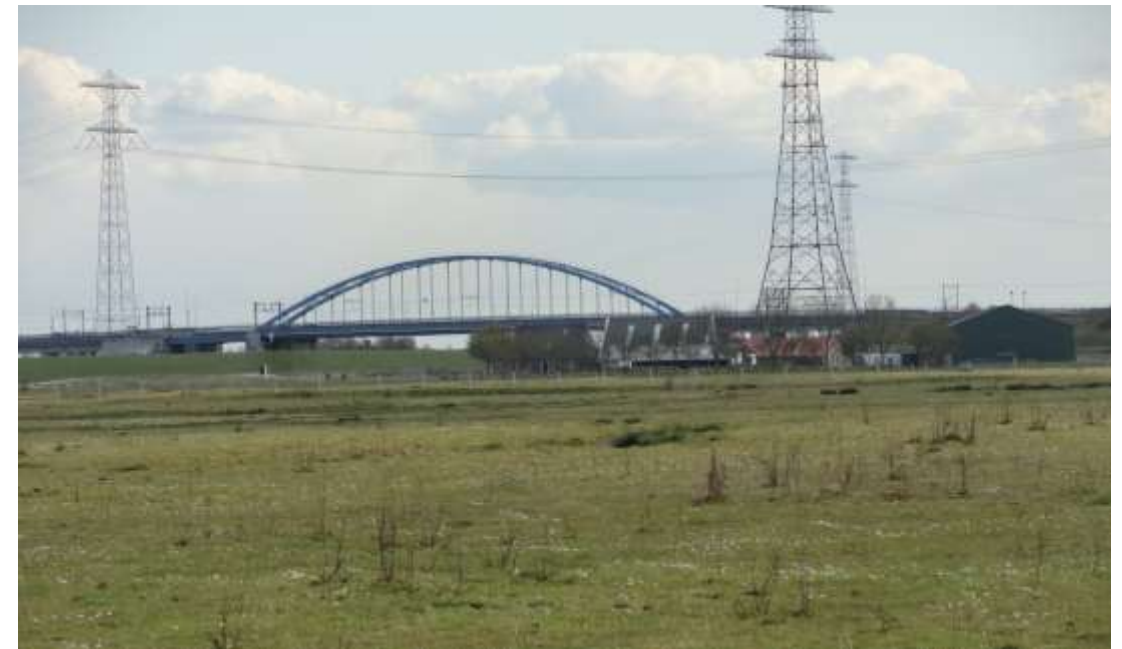
Grootschalige infrastructuur: Kanaal, spoorlijn en hoogspanningstracé
