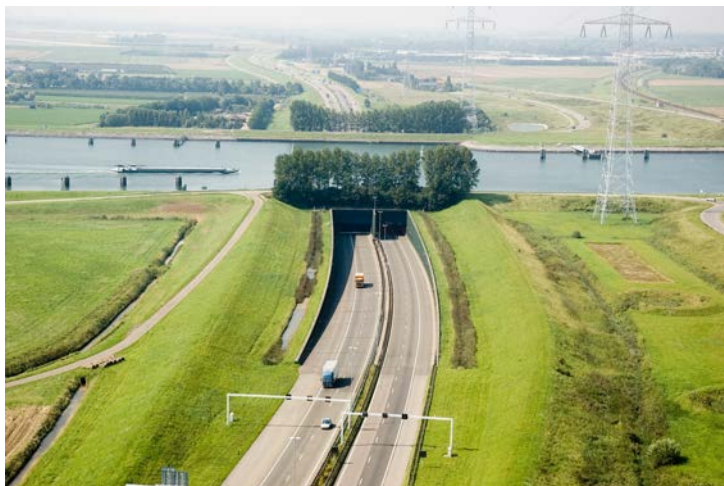
Beeldbepalende infrastructuur op een luchtfoto uit 2005: de snelweg A58, het spoor, het kanaal met de Vlaketunnel, hoogspanningstracé. Bron; beeldbank Rijkswaterstaat / Joop van Houdt.
