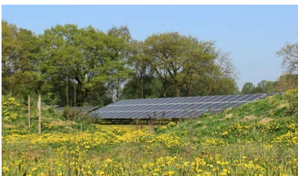
Voorbeeld: een zonnepark waar ook geïnvesteerd is in het landschap en de lokale biodiversiteit
