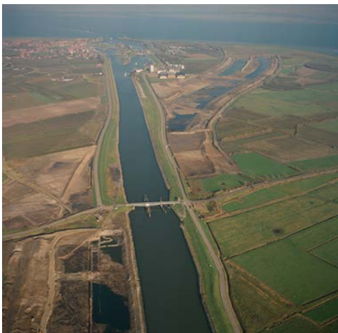
Het kanaal door Zuid-Beveland tijdens de werkzaamheden in 1989, met de Postweg en postbrug midden in het beeld, en de sluis en het dorp Wemeldinge bovenaan. Bron; beeldbank Rijkswaterstaat / Bart van Eyck.
